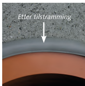
Pakningen er komprimert og tetningen er fullført
