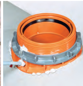
Ekspansjonsharpiksen blir introdusert gjennom fyllingsåpningen i avstandsringen med patron og blanderøret
